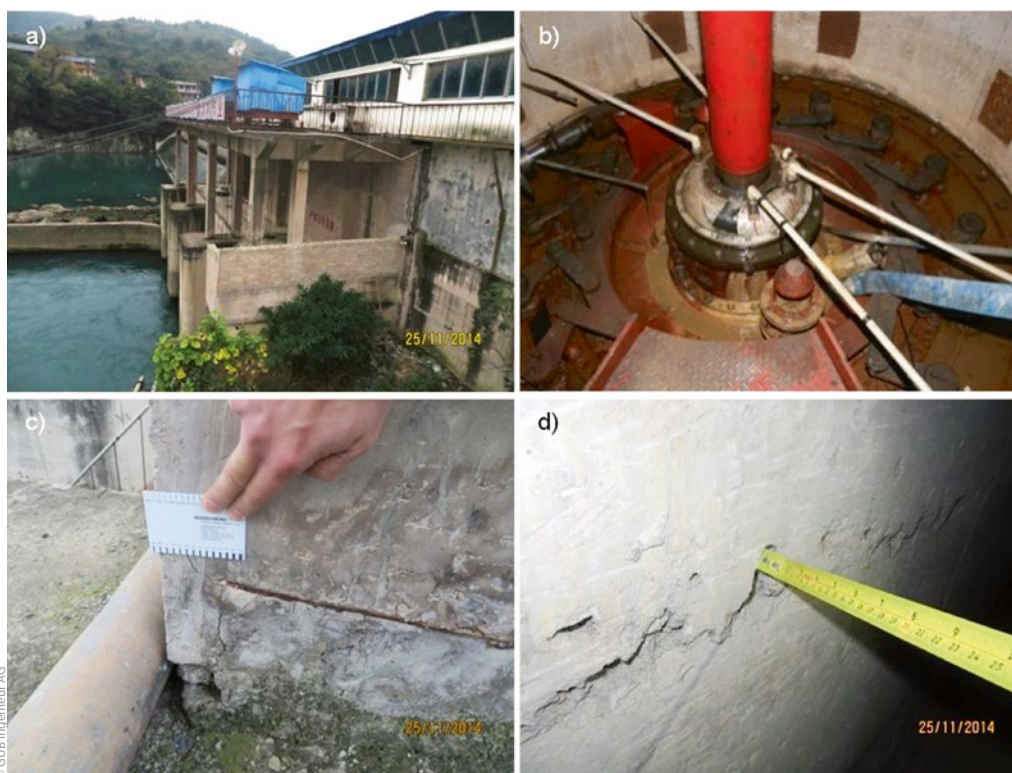
Bild 2: Befunde am Kraftwerk Fujiang: a) Bemessung, Aussinterung wegen Durchfeuchtung, b) Korrosion in einer Turbinengrube, c) Risse und freiliegende Bewehrung am Stützenfuß, d) grobporige Betonoberfläche, Lunker
