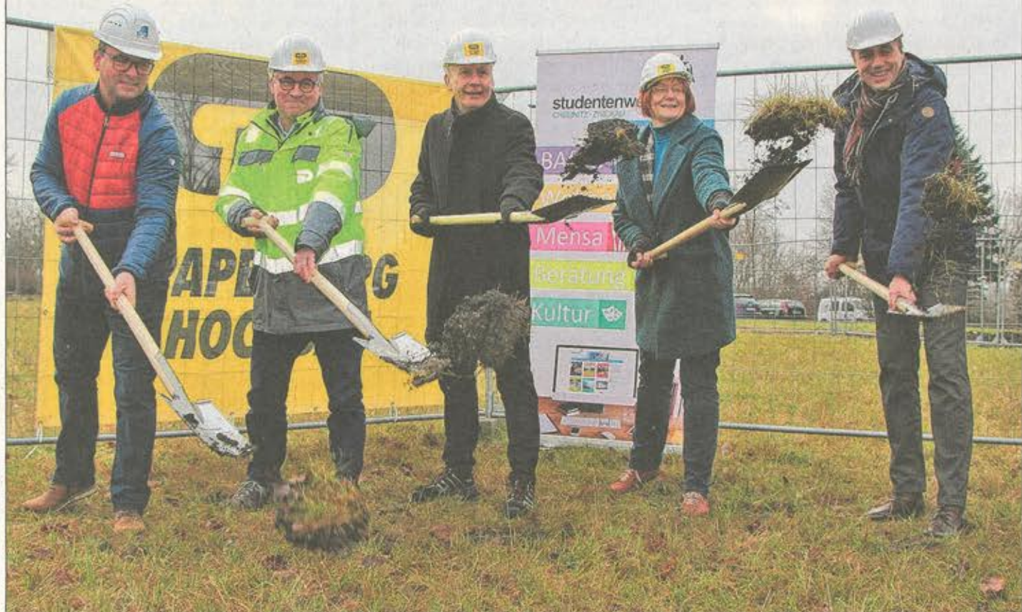
AN DER MAKARENKOSTRASSE, IN NACHBARSCHAFT ZUM ALTEN STUDENTENWOHNHEIM, ERFOLGTE GESTERN VORMITTAG DER SPATENSTICH FÜR EINEN WOHNHEIMNEUBAU. IN DEN BAU INVESTIERT DAS STUDENTENWERK CHEMNITZ-ZWICKAU RUND 12 MIO. EURO. DAS GESAMTE BAUVORHABEN WIRD VON DER FIRMA GP PAPENBURG HOCHBAU GMBH AUS HALLE ALS GENERALUNTERNEHMEN SCHLÜSSELFERTIG UMGESETZT, DIE ENTWURFS- UND AUSFÜHRUNGSPLANUNG WURDE DURCH DAS BÜRO S&P INGENIEURE + ARCHITEKTEN UMGESETZT. FOTO: STADT ZWICKAU
