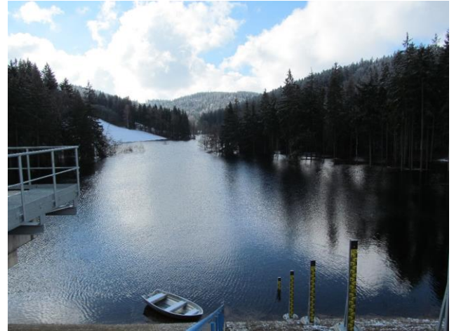
Abbildung 5: Stufenpegel auf Wasserseite Dammbauwerk
