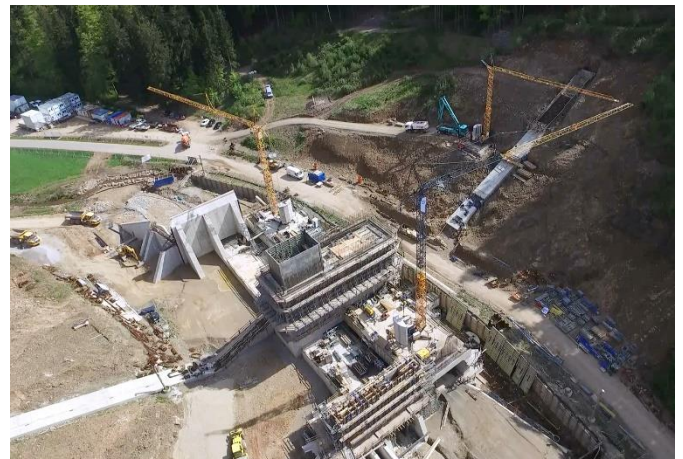
Abbildung 3: Baustellenbefliegung vom Mai 2017
