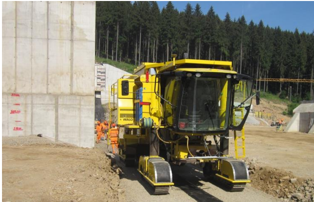
Abbildung 10: Asphaltfertiger bei Herstellung der AID 2018
