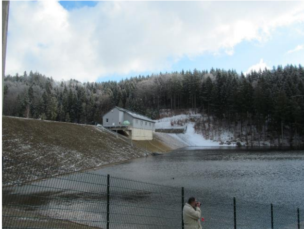
Abbildung 4: Ansicht Wasserseite Damm und Stufenpegel
