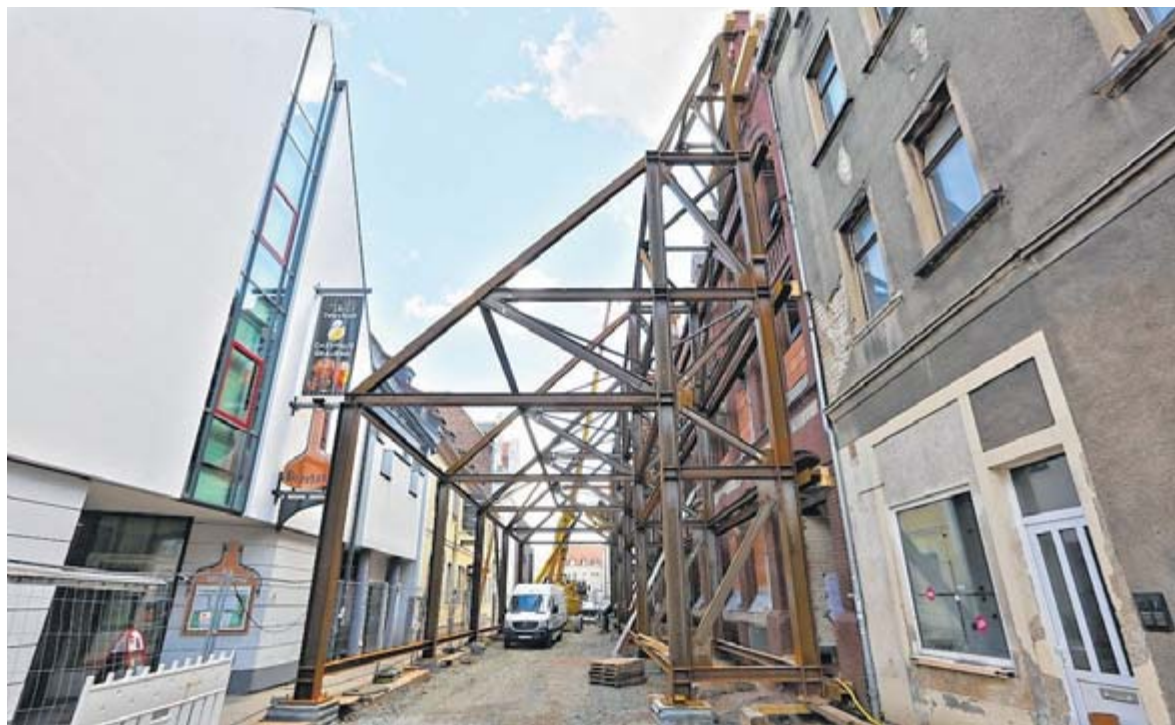
Diese Stahlkonstruktion auf der Breuerstraße stützt die Klinkerfassade ab.
