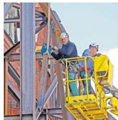
Arbeiter bei der Montage der Konstruktion mittels Hebebühne.
