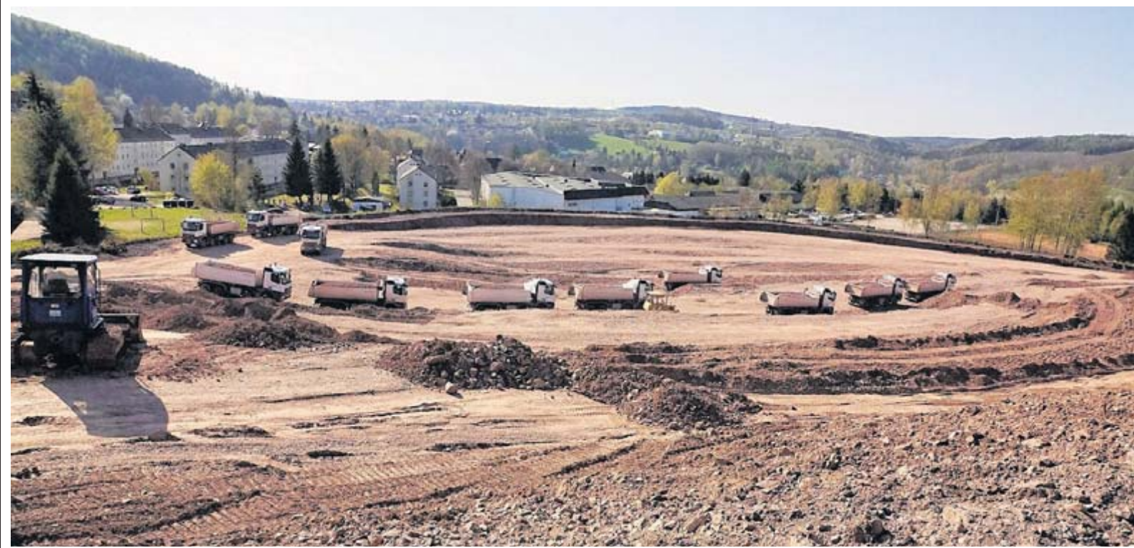
In Bad Schlema wird derzeit nahe dem Kurzentrum die Halde 65 abgetragen und ein Großteil der Fläche zur uneingeschränkten Nachnutzung saniert. Sie wurde bis 1957 aufgeschüttet, ein Jahr später der Schachtbetrieb eingestellt. Sanierungskosten: acht Millionen Euro.
