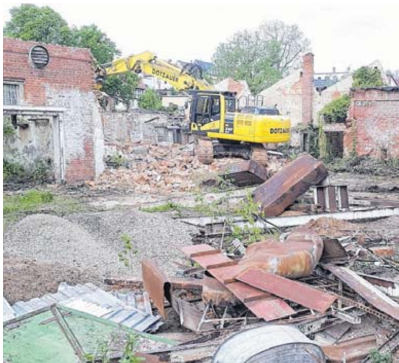
Die Brache an der Straße Rosental ist dem Erdboden gleich gemacht worden. Nun beginnt die Umgestaltung zur Grünfläche. FOTO: G.U.B. INGENIEUR AG
