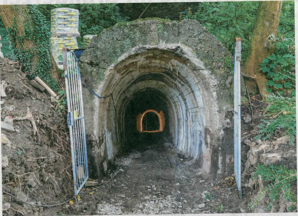
Der Vorschlag des Bürgervereins sah vor, lediglich den oberen Bereich des Torbogens zu erhalten und in eine Gedenkstätte umzuwandeln. Da die Politik dies ablehnt, wird das gesamte Bauwerk nun eingeebnet.
