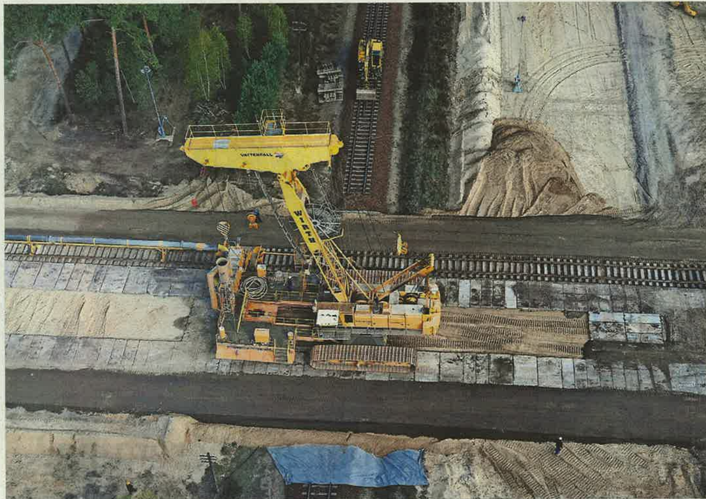
Umzugstag am Tagebau für das Schlitzfräsegerät. Der 260 Tonnen schwere, 150 Meter lange Koloss überquert am Freitag die Bahnlinie Cottbus – Görlitz. Dafür sind in der Nacht zuvor die Gleise gekappt, Schwellen und Schotter weggeräumt und eine Trasse für die Spezialfräse gebaut worden. Für Zugreisende heißt das noch bis Sonntagmittag Schienenersatzverkehr.
